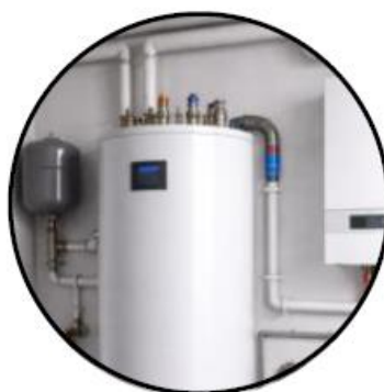
Erneuerung der Heizungsanlage
